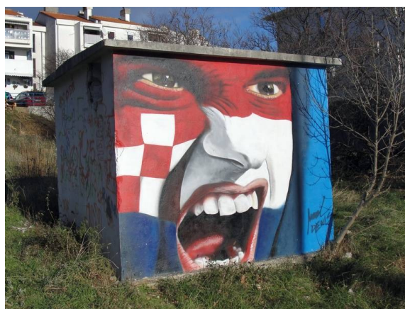
Slika 70. Oslikan zid trafostanice s likom hrvatskog navijača
